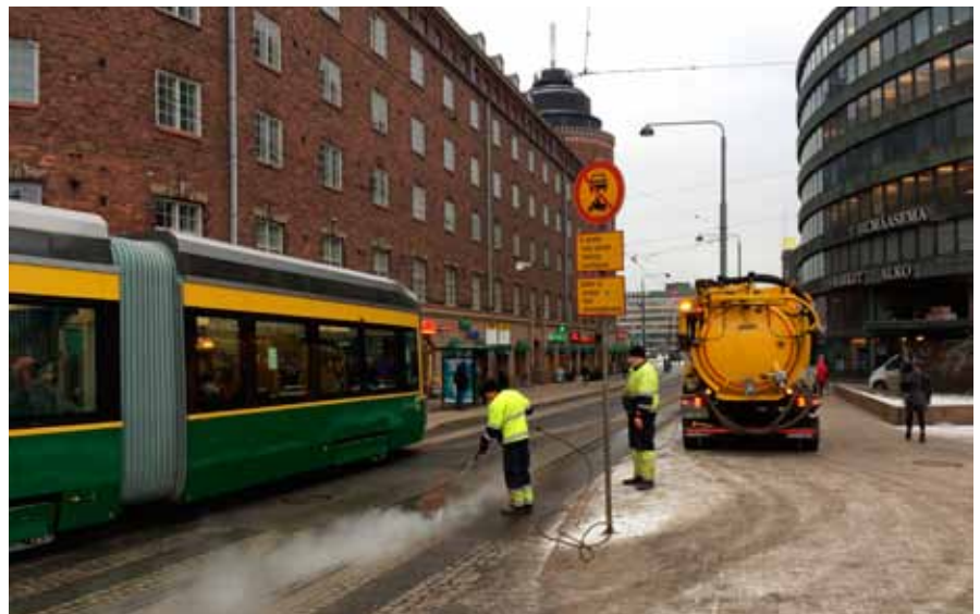
Erityisesti talvisaikaan HKL:n kunnossapitoautot kiertävät puhdistamassa vaihteita. Kiskourat vaihteen kielien kohdalla pestään huolellisesti ja tarvittaessa kiskokaivoihin kertynyt moska imuroidaan. Runsaslumisina talvina työ on ajoittain hälytysluonteista. Kuva Daniel Federley 3.2.
