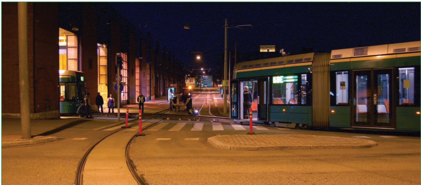
Klo 0.34. Tilapäinen raide on saatu kasattua eli se ylittää toisen suunnan linjaraiteen ja jalkakäytävän. Kohta voidaan aloittaa vaihtotyöt.
