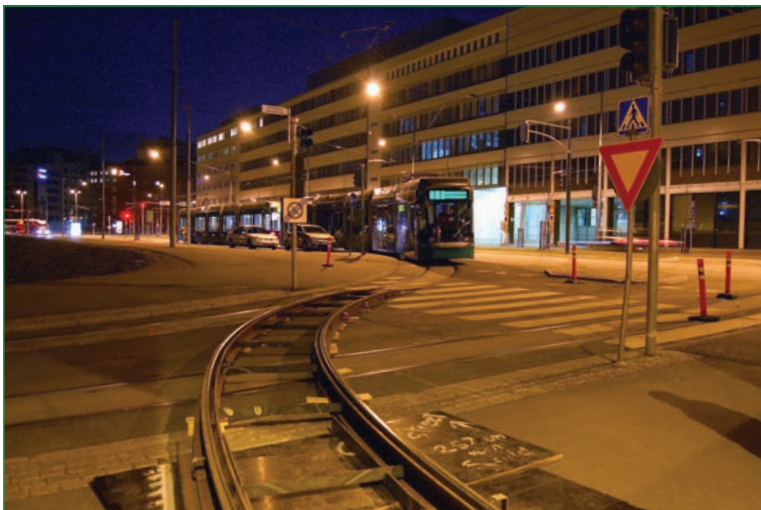
Klo 0.49. On päästy Teollisuuskadulle ja vau- nut irrotetaan toisistaan. Tilapäisraiteen sijoitus linjaraiteiden yli nähdään tässä kuvassa.
