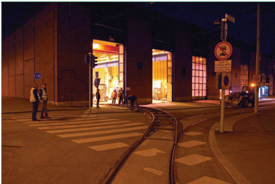
Klo 0.34. Tilapäinen raide on saatu kasattua eli se ylittää toisen suunnan linjaraiteen ja jalkakäytävän. Kohta voidaan aloittaa vaihtotyöt.
