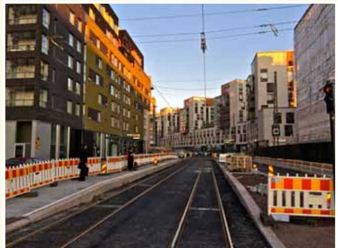
Huutokonttorin pysäkillä työt ovat loppusuoralla: katokset ovat paikoil- laan, joskin ilman laseja. Pysäkkikilvistä puuttuvat vielä pysäkin nimi ja tyhjät päreet. Kiveystöitä ei ole enää kovin paljon jäljellä, mutta ai- dat puuttuvat vielä kokonaan. Silti tuliterä pysäkki kelpaa ainakin näil- le kahdelle aamuvirkulle, jotka odottelivat linjan 9 ensimmäistä vaunua 14.8.2017 jo kello 5.53, varttia ennen sen saapumista. Kuvassa näkyy myös uusi jaksoerotin 131. Välimerenkadun toisessa päässä on uusi erotin 130. Kuva Daniel Federley.
