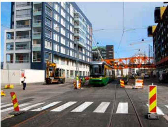
Artic 430 Välimerenkadulla ”harjannostajaisajolla” 11.8.2017. Kilvis- sä lukee Tilausajo. Vaunu on juuri alittanut Hyväntoivonpuiston sillan ja saapunut Välimerenkadun vielä keskeneräisen pysäkin kohdalle. Kun ol- laan kaupungin uusimmalla radalla, on tietysti paikallaan, että ajallaan kaupungin uusimmalla vaunulla! Vaunu 431 oli päivää aiemmin saapu- nut Otanmäestä, mutta viimeistelyt olivat vielä kesken, joten 430 oli tuo- na päivänä kaupungin usin liikennekelpoinen vaunu. Kuva Daniel Feder- ley.
