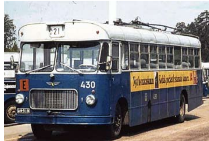
HKL 430. Johdinautolinjan ajolankojen huurteenpoistoauto. Kuva Arto Hellman.
