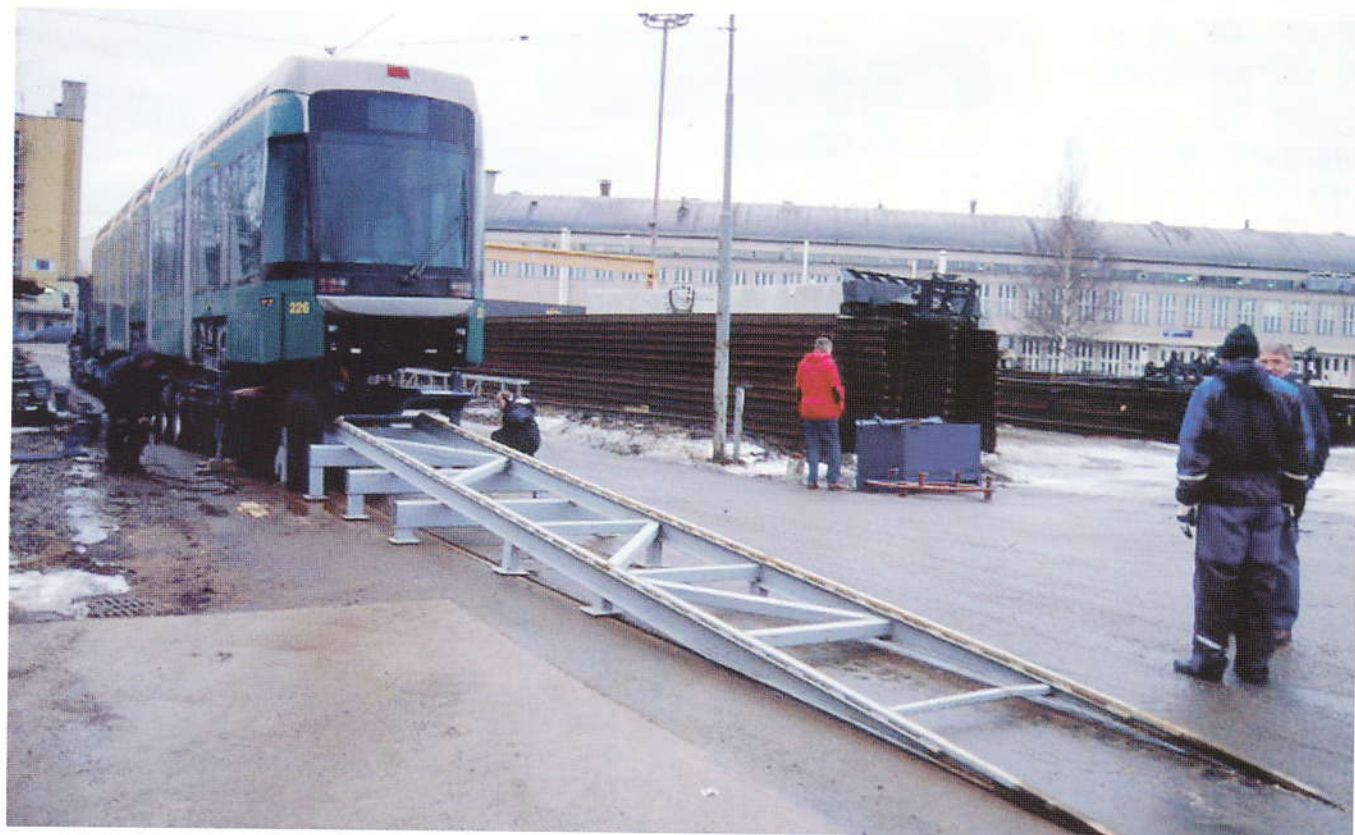
Yläkuvassa Variotram 226:n kiskoillelasku on alkamassa Koskelan varikolla. Alaslaskuramppi on jo tuotu rekan perävaunuun kiinni. Kuva Jorma Rauhala 19.2.2002.
