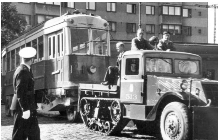
Sotien jälkeen 1940-luvulla HKL hankki kolme (nrot 511-513, rek.nrot vastaavasti AL-836, AN-408 ja AN-314) White Half Truck -autoa, joita käytettiin erillisen kuljetusperävaunun vetoon. Kuvassa White nro 513 vetää perävaunua, jossa on Suomen Autoteollisuuden valmistama moottorivaunu HKL:n sarjasta 163-180. Kuva 1950-luvun puolivälistä.
