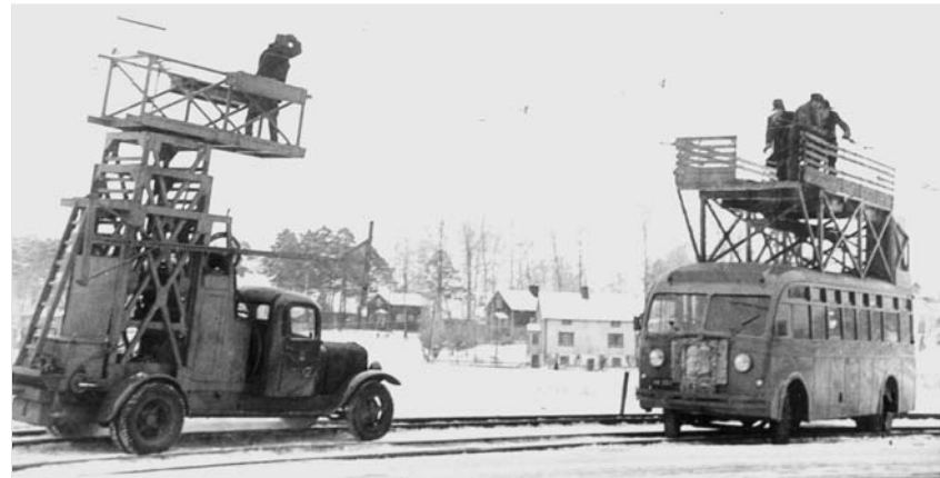
Republic nro 502 Kustaa Vaasan tien ajojohtotöissä Volvo-bussista tehdyn torniauton nro 504 kanssa 18.2.1954.
