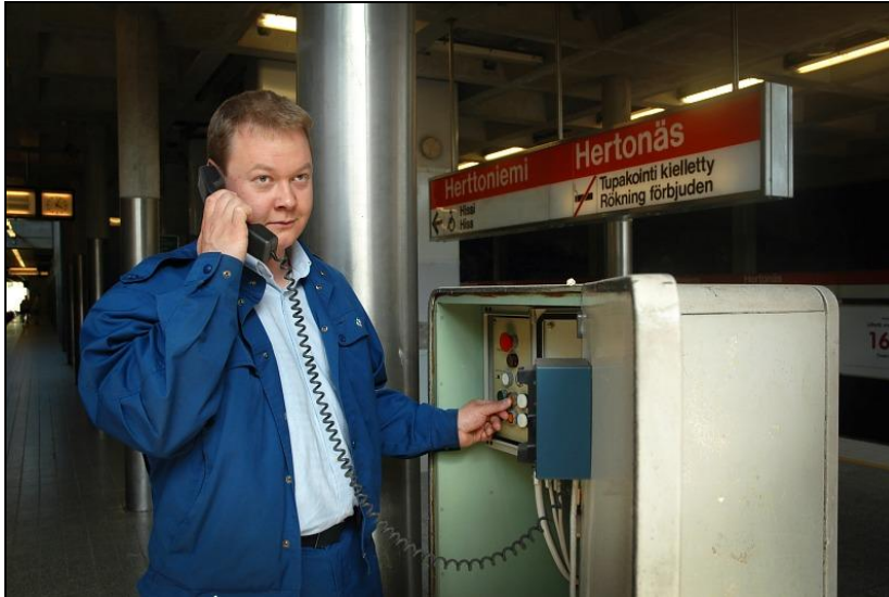
Kuva 7. Lavastettu junanlähetystilanne Herttoniemen 1-laiturin varalähetyspaikalla. Koska käytönohjausjärjestelmän hankintaa lykättiin, ajateltiin metroliikenteen alkamisen kynnyksellä, että laiturivalvojat antaisivat ovien sulkemiskäskyt ja lähtöluvat kuvan tapaan varalähetyspaikoilta. Koko junanlähetyskäytännöstä kuitenkin luovuttiin ennen matkustajaliikenteen alkua. Pikkukuvissa näkyvät aseman lähtöopastimien yhteydessä olevat junanlähetysopasteet, joiden mukaan junanvalvoja olisi hoitanut ovitoiminnot: O = sulje ovet, L = lähde. Opasteen käyttö voitiin korvata asentamalla juniin sivupeilit. (Hietaranta 2006, Koskinen 2006).
