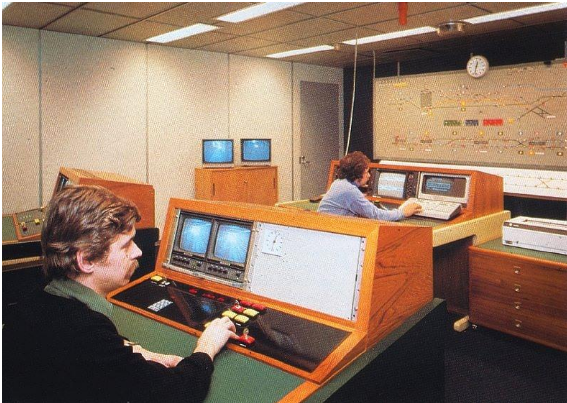
Kuva 6. Herttoniemen aluevalvomo 1970-luvun lopulla, muutamaa vuotta ennen matkustajaliikenteen alkua. Taustalla näkyy sittemmin vuoteen 2012 saakka palvelleeseen Siemensin releasetinlaitteen ilmaisintaulu. Sen edessä istuva liikenteenohjaaja näppäilee koekäytössä ollutta Hamburg-Consult GVV:n ohjelmistolla toimivaa käytönohjausjärjestelmää. Kuvan etualalla istuva liikenteenohjaajan apulainen on puolestaan valmiina antamaan junalle lähtölupaa laiturikamerakuvien perusteella. Kuva HKL:n arkistosta, tiedot Heikki Koskinen (2006).
