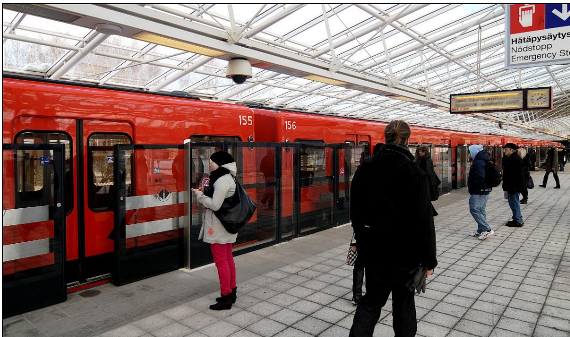
Kuva 8. Laituriovet koekäytössä Vuosaaren asemalla. Kuvan kaltaiset, 170 cm korkuiset laiturioiviseinät on määrä asettaa Helsingin nykyisille metroasemille. Länsimetron asemat varustetaan jo alkujaan täyskorkeilla laiturioilla. Kuvan laiturinäytöt ovat 1990-luvun alun mallia ja ne on korvattu vuoden 2012 aikana uusilla. (HKL-Metroliikenne 2013c, Hietaranta 2012.)
