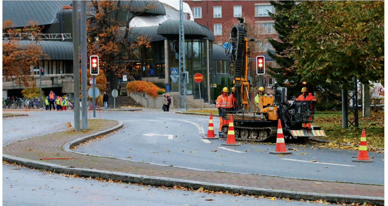
Kuva: Maaperätutkimuksia Pirkankadulla syksyllä 2015. Raitiotieallianssi/Jussi Takamaa.
