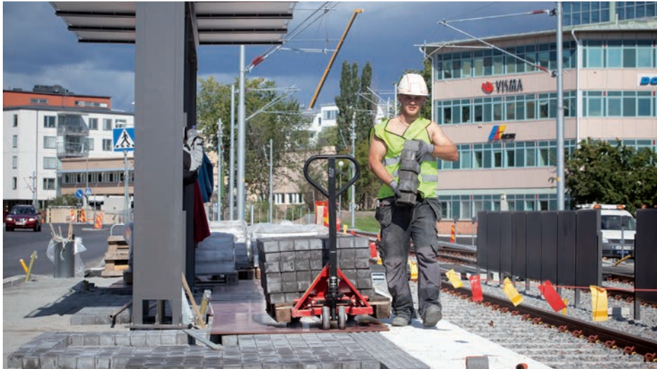
Kuva: Pysäkin rakentamista Tukholmassa. Ratatek.
