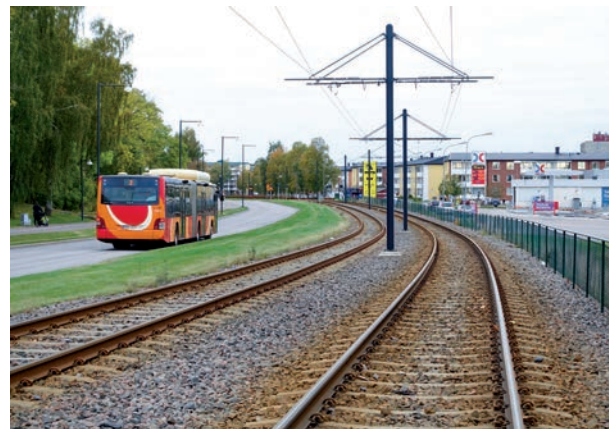
Kuva: Avorata betonipölkkyin, Vignole-kiskoilla, Norrköpingin esikaupunkialueella. Tampereen kaupunki/Alkutieto Oy.
