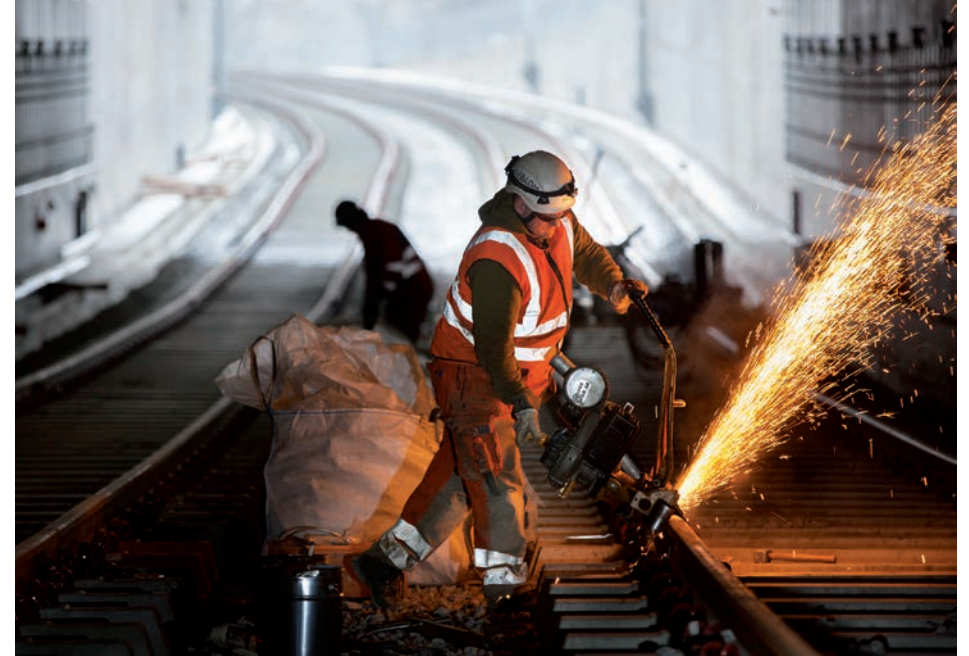
Kuva: Raitiotien rakentamista Tukholmassa. Ratatek.
