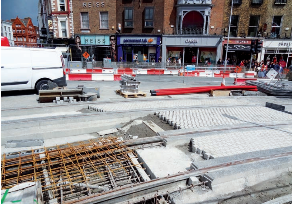
Kuva: Raitiotien rakentamista Dublinissa. Raitiotieallianssi/Ville-Mikael Tuominen.
