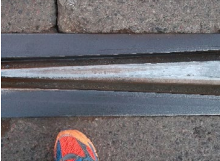
Kuva: Urakiskollinen kiintoraide rakennetaan osaksi kadun luonnonkivistä päällysrakennetta likimain muun kadunpinnan tasoon. Mikael Wuorinen.
