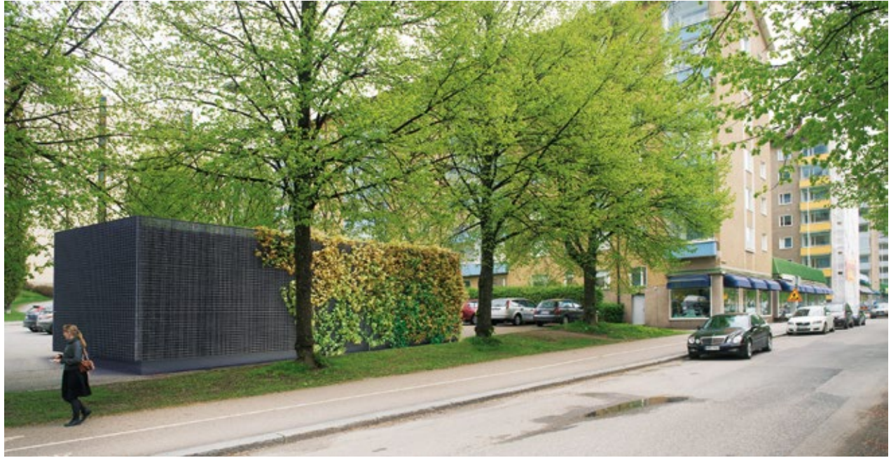
Kuva: Arkkitehtonisin keinoin toteutettuna sähkösyöttöasemien julkisivurakenne, -valaistus ja -kasvillisuus mahdollistavat paikallisidentiteetin näkymisen. Aihio Arkkitehdit Oy.
