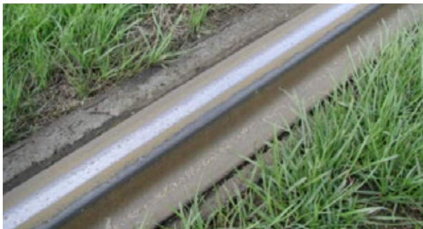
Kuva: Raitiotievaihtoehto mahdollistaa kadun päällystetyypin, jossa nurminauhat kulkevat kiskojen vieressä ja välissä ns. viher- tai nurmiratana. Viherratana tulee katkoksia pysäkki-, katuristeys- ja vaihdealueilla.
