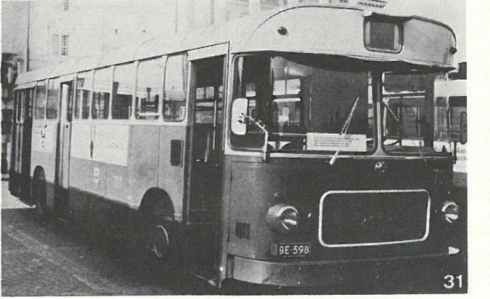
kuva 2: Leyland Royal Tiger ovet 1-002-2 HKL not 660-664 hankintavuosi 1965 alusta: Leyland Motors Co., UK kori: Ajokki Oy, Tampere
