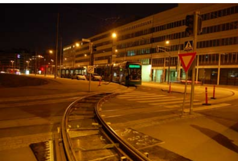
Klo 0.49. On päästy Teollisuuskadulle ja vau- nut irrotetaan toisistaan. Tilapäisraiteen sijoitus linjaraiteiden yli nähdään tässä kuvassa.
