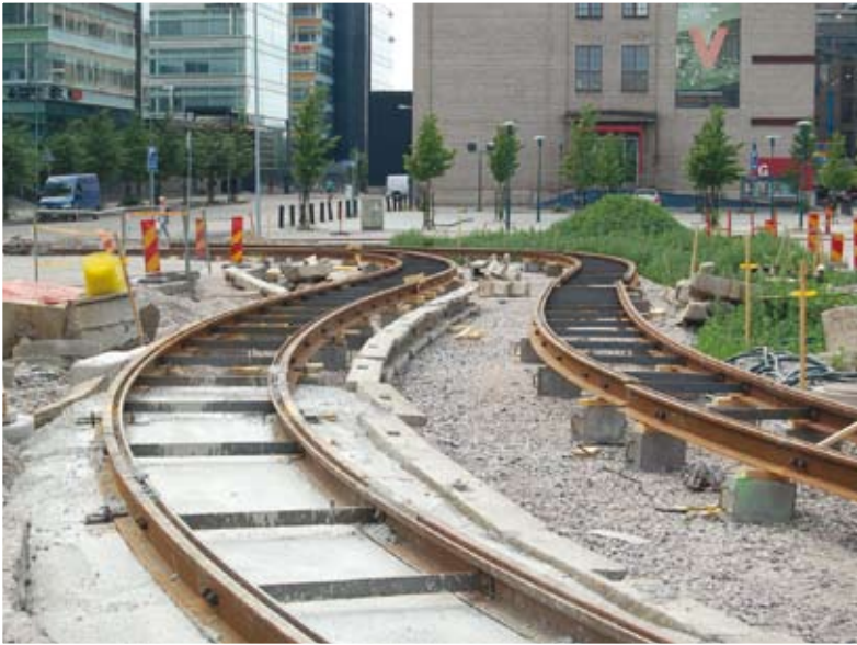
Kiskot asennettiin paikoilleen Länsisatamankadun ja Kellosaarenkadun risteykseen keskikesällä. Taustalla näkyy vanhan kaapelitehtaan kiinteistöjä. Kuva Juhana Nordlund 18.7.2010.
