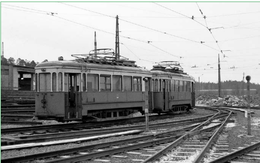
Vaunut 219 (vas.) ja 220 (oik.) odottavat lopullista hävitystä Koskelan romuriteella "Umpisuo- lessa". Vaunun 219 tunnusmerkinä on katolla vain yksi vastuslaatikko ja helmapeltien suorakul- maisuus. Etualalla on kaksi opastinpylvästä, jotka liittyvät huoltohallin vaihtotöiden turvaamiseen. Kuva JR 23.10.1970.
