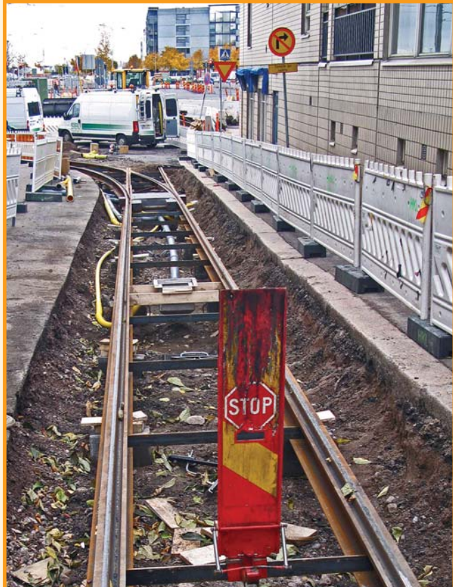
Jätkäsaaresta tulevia vaunuja varten on jo asennettu vaihde Ruoholahdenrantaan. Kuten asfaltista näkyy, on kiskojen uusimisen yhteydessä myös kaarretta loivennettu. Kuva Arto Hellman 3.12.2009.
