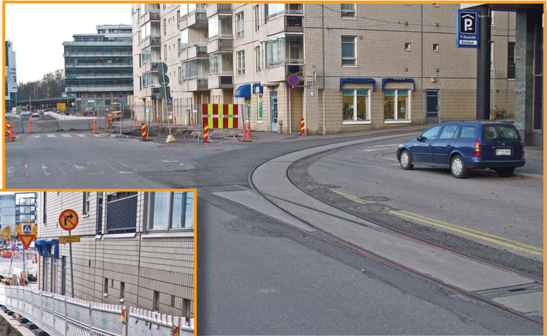
Jätkäsaaresta tulevia vaunuja varten on jo asennettu vaihde Ruoholahdenrantaan. Kuten asfaltista näkyy, on kiskojen uusimisen yhteydessä myös kaarretta loivennettu. Kuva Arto Hellman 3.12.2009.
