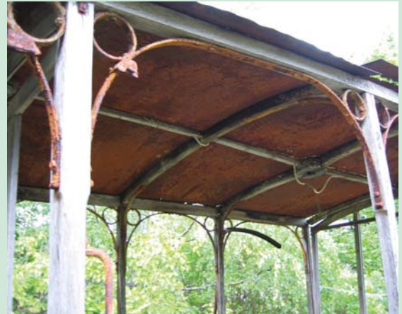
Vaunu 233 huvimajana Lohjalla 5.9.2006. Vaunu on päässyt jo huonoon kuntoon, mutta kaikki pienmetalliosat osoittautuivat käyttökelpoisiksi, samoin monet puuosat, kuten kuvassa näkyvät penkit, olisi voinut käyttää uudelleen.
