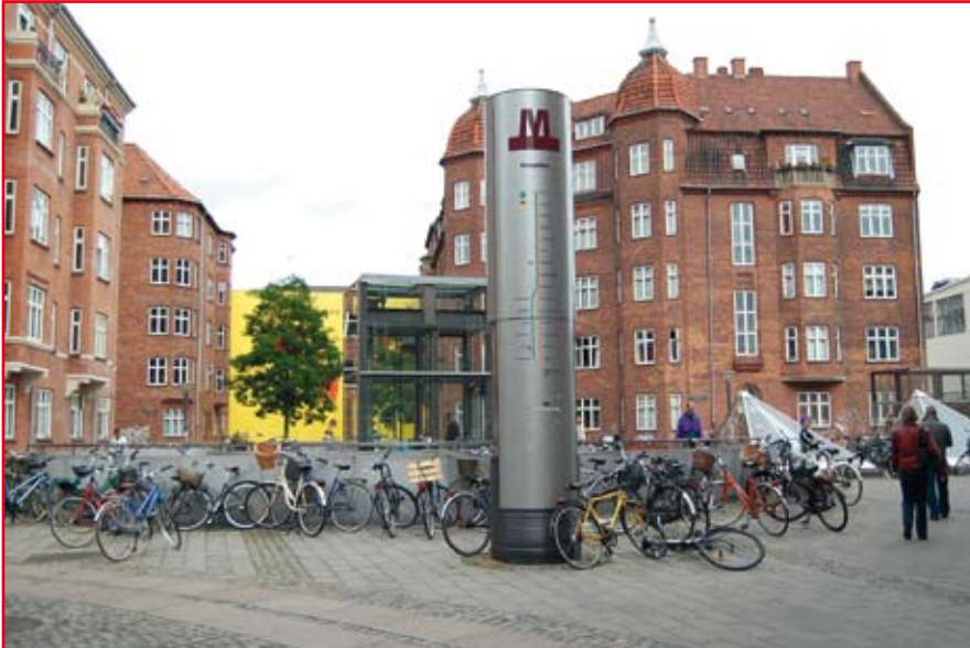
Amagerbron metroaseman logo sekä sisäänkäynnin lasikatot yms. rakennelmia. Tunneliasemille johdetaan päivänvalo erilaisten ikkunoiden avulla. Kuva Juhana Nordlund 8.7.2008.
