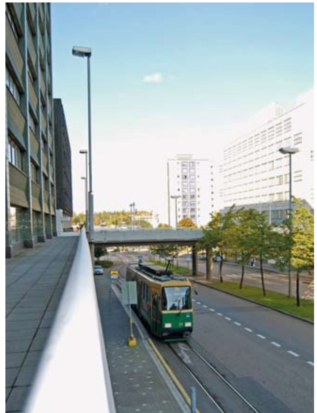
Itä-Pasilassa raitiovaunukiskot sijoitettiin tavanomaisesta poiketen kadun reunaan. Jalankulku tapahtuu pääosin katutaso yläpuolella, ja kuvassa näkyvälle pysäkillä kuljetaan portaita pitkin. Taustalla näkyvä Kellosilta ylittää leveän Ratamestarinkadun raitiovaunupysäkin kohdalta, joten myös vastakkaisen suunnan pysäkillä pääsee kätevästi portaita pitkin ylätasolle. Kuva Daniel Federley 24.9.2008.
