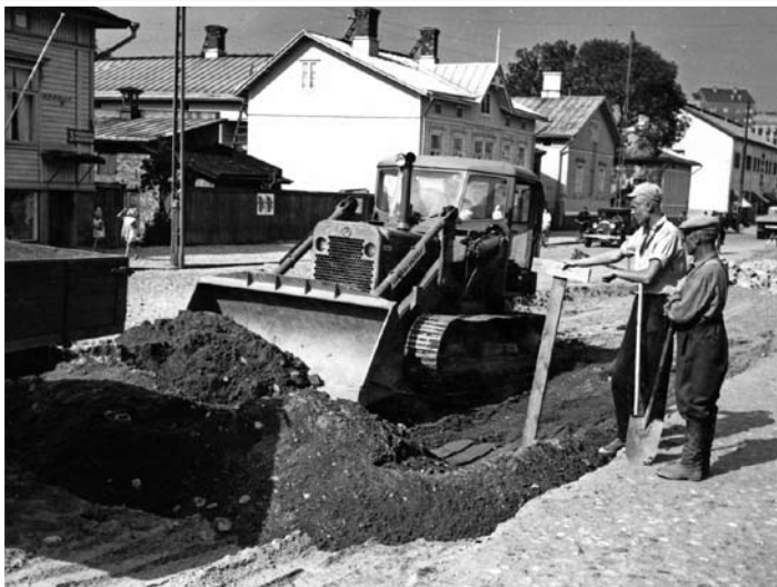
Maansiirtotyöt käynnistyvät Stålarinkadulla, heinäkuu 1956. TuKL.
