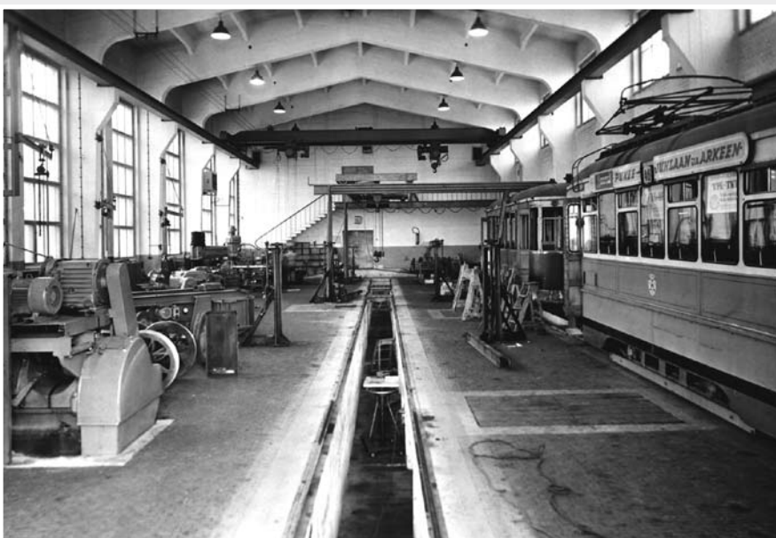
Raitiovaunukorjaamo 1958. Liikennelaitos teki täällä mittavia korjauksia, kuten oikealla näkyvän perävaunun täyskorjauksen ja vaunun 46 muutokset. TuKL.
