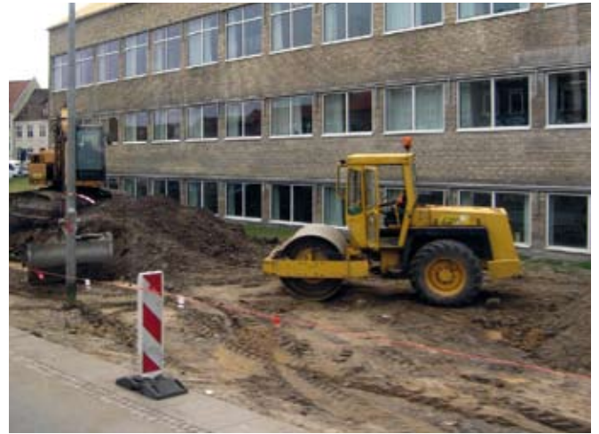
Århusin raitiotielle mitoitettujen joukkoliikennekaistojen rakentaminen Randersvej – tielle on käynnistynyt, 19.6.2008. Mikko Laaksonen.
