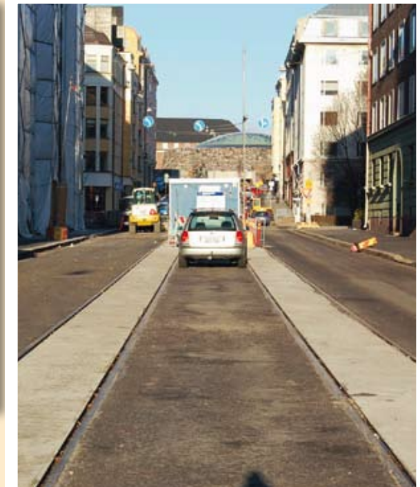
Fredrikinkadun kiskotusta Pohjoisen Rautatiekadun ja Arkadiankadun välisellä osuudella. Kuva Juhana Nordlund 4.11.2007.
