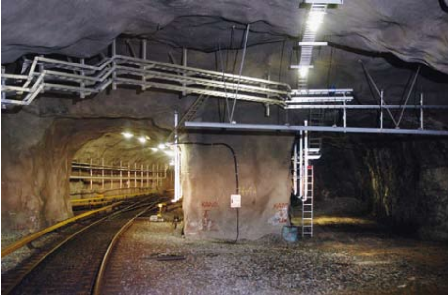
Näkymä Ruoholahden asemalta kääntöraiteen suuntaan. Oikealla näkyy louhittuna muutama metri Länsimetron tulevaa linjasta. Kuva Juhana Hietaranta, 16.1.2007.
