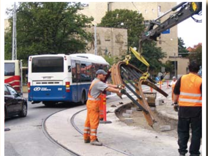
Kampin raitiotie heijastuu myös Töölön raidejärjestelyihin. Tässä ollaan yhdistämässä Arkadiankadun uusittua linjausta Runeborginkadun vanhaan linjaukseen. Kuva Juhana Nordlund 8.9.2007, Helsinki.
