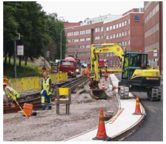
Heinäkuussa työt kävivät kuumina mm. Kumpulantiellä. Kuva Juhana Nordlund 10.7.2007.
