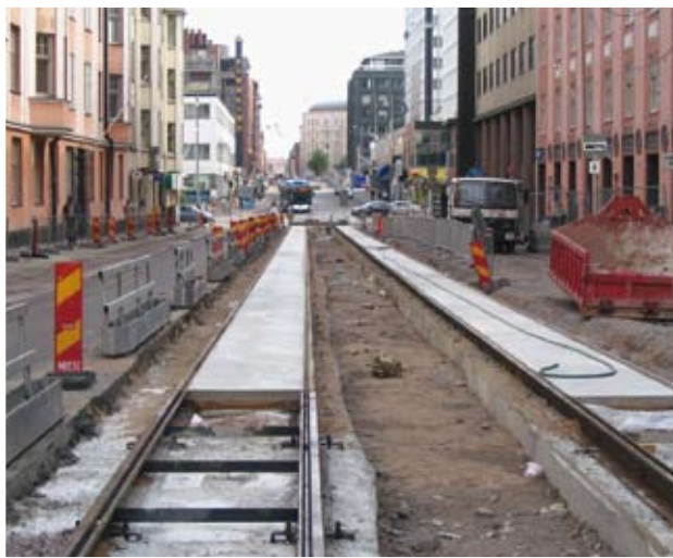
Fredan pohjoispään kiskotusta jo betonivalut saaneena. Kuva J. Nordlund 12.8.2007.
