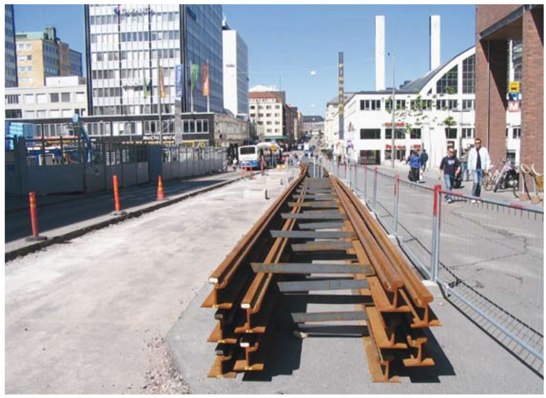
Kiskotus Fredrikinkadulla Kampin metroaseman kohdalla on alkamassa. Kuva Juhana Nordlund 2.6.2007.
