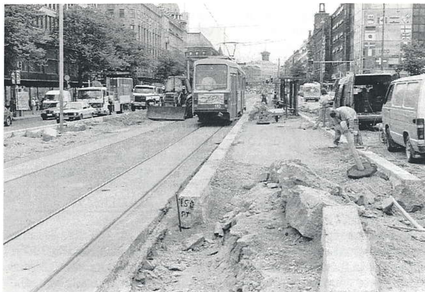
Postitalon raitiotiepysäkin laitureiden korottamistyöt ennakoivat matalalattiaraitiovaunujen tuloa; vaunun lattiataso sekä laituritaso ovat samat ja vaunuun on siten helppo mennä ja tulla. Kuva M Nummelin 21. 7. 1993.
