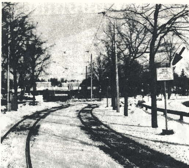
Helsingin raitioteillä on kaksi vaiheopastinta. Toinen on Mäkelankadulla Radanrakentajantien erkanemisvaihteella. Se on kirjallinen ja kehottaa varmistaan vaihteen asennon sekä suomeksi että ruotsiksi. 1977-03-27.
