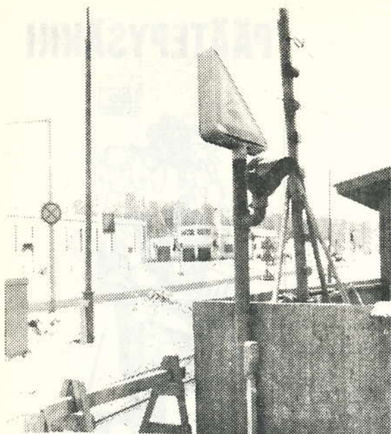
Salmisaaren viinavaraston rakennustyömaan varoitusviilku katosi vuoden 1977 aikana.
