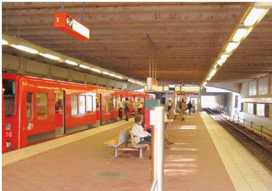
Kontulan aseman laiturihalliin syksyllä aloitettu remonti ei juuri ulotu. Kuvaa on vaalennettu, jotta pimeähköstä hallista näkyisi paremmin rakenteita. Kuva Jorma Rauhala 7.9.2006.
