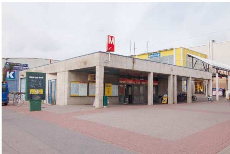
Kontulan (vasta) 20 vuotiasta asemaa on ryhdytty korjaamaan. Kuvan asemarakennus eli itäinen lippuhalli suljettiin lokakuun puolivälissä. Kunnostus- ja muutostöiden pitäisi olla valmiina ensi kesällä. Kuva Jorma Rauhala 7.9.2006.
