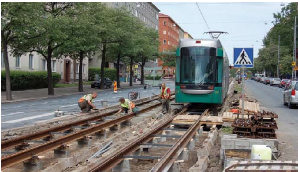
HKL 213 Mannerheimintielle Töölön Tullin ja Kuusitien välisellä ratatyömaalla. Oy VR-Rata Ab:n Vuorenteikot-tulosyksikkö uusii paikalla kapearaiteista rataa. Ainoat ratapölkkyt, joita työmaalla käytetään, ovat perustuksen tukimuuriin käytettävät vanhat VR-levyäraidebeto- nipölkkyt, joita näkyy myös kuvassa. Kuvat Jorma Rauhala 8.6.2006.
