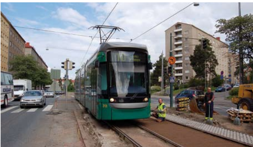
HKL 213 Mannerheimintielle Töölön Tullin ja Kuusitien välisellä ratatyömaalla. Oy VR-Rata Ab:n Vuorenteikot-tulosyksikkö uusii paikalla kapearaiteista rataa. Ainoat ratapölkkyt, joita työmaalla käytetään, ovat perustuksen tukimuuriin käytettävät vanhat VR-levyäraidebeto- nipölkkyt, joita näkyy myös kuvassa. Kuvat Jorma Rauhala 8.6.2006.
