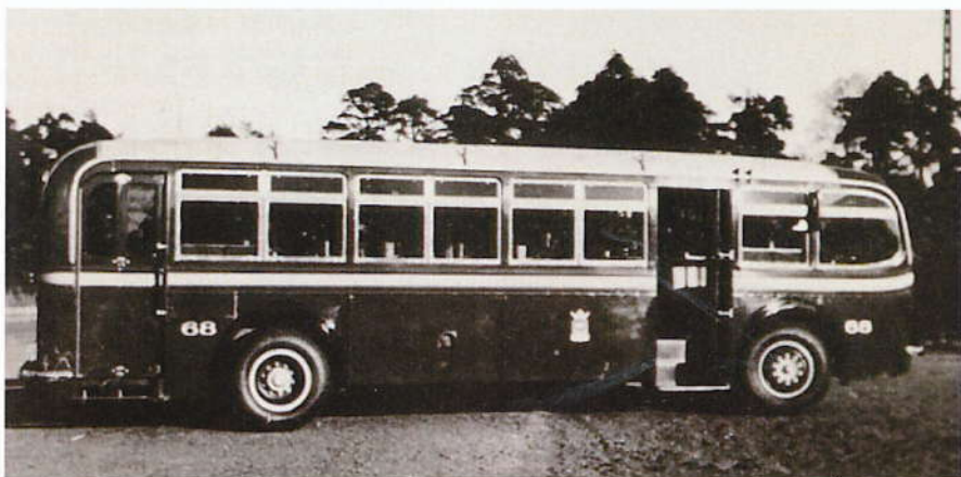
Vasemmalla ja alhaalla olevat kuvat Helsingin kaupungin liikennelaitos 68, Sisu SHDRXB101 / Oy Suomen Autoteollisuus Ab vuodelta 1938. Kuva Oy Suomen Autoteollisuus Ab.
