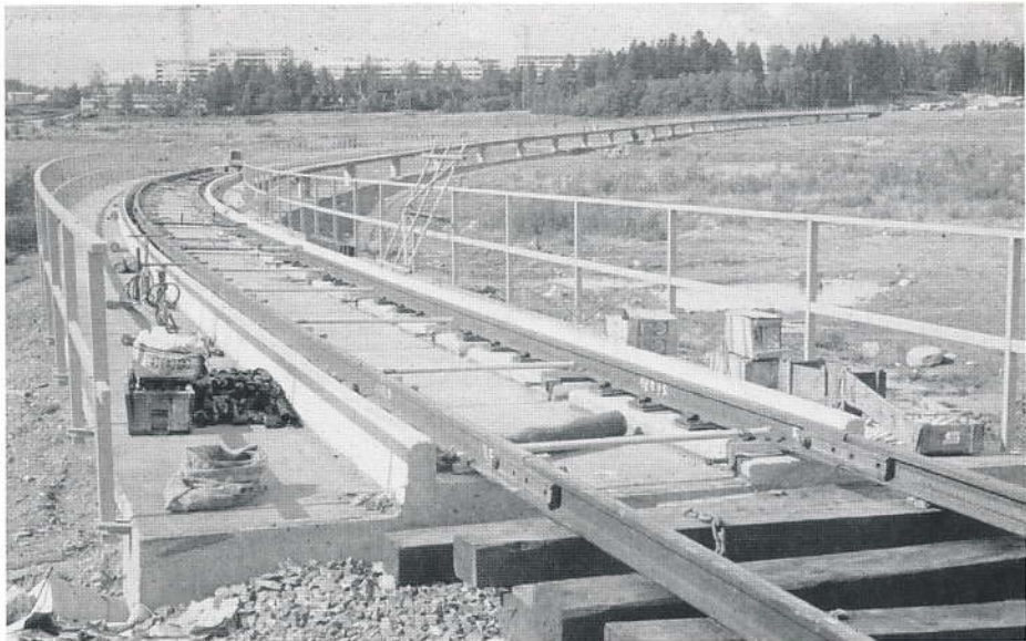
Ovatpa maisemat muuttuneet sitten tämän kuvan ottamisen: Metrolinjalta metrovarikolle johtava yksiraiteinen silta on valmistunut ja kiskotustyöt päässeet käyntiin. Taustalla Puotinharjun kaupungin osan Kajaaninlinnan tien kerrostaloja. Kuva: Mikko Alameri 1.9.1971
