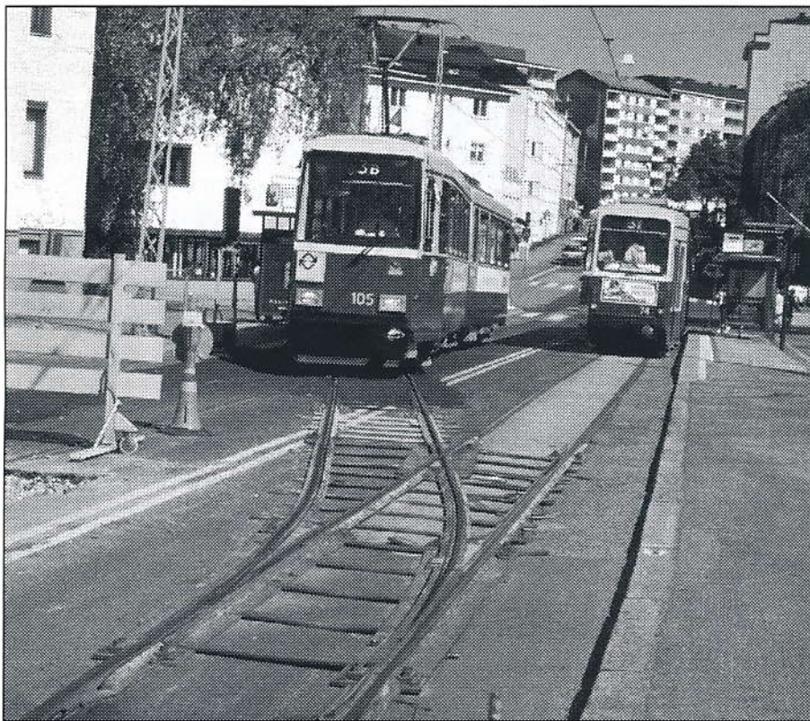
PINTAVAIHTEILLA ON TÄNÄKIN KESÄNÄ HOIDETTU PARIN SUUREN RATATYÖMAAN OHITTAVA LIIKENNE. LIIKENNETTÄ OHJATAAN OPASTINJÄRJESTELMÄLLÄ, JOLLOIN VAUNUT EIVÄT OLE SAMAAAN AIKAAN YKSIRAITTEISELLA OSUUDELLA. SAMAAIN AIKAAN TOINEN RAIDE ON TYÖN ALLA. KUVA VIIPURINKADULTA ALPPILAN KIRKON PYSÄKILTÄ, JORMA RAUHALA 14.6.2000.
