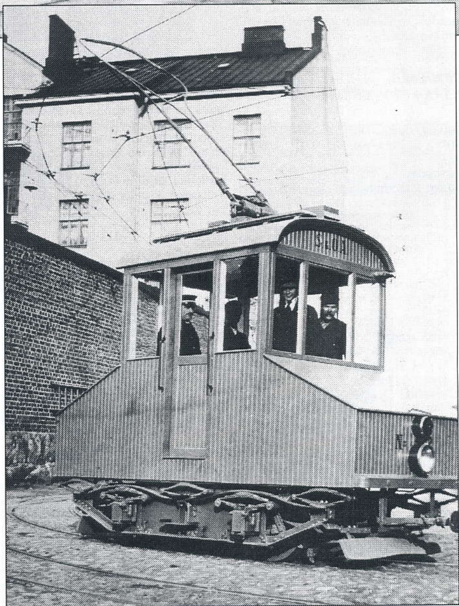
TYÖVAUNU 2 ELOKUJUSSA 1952 VALLILAN HAL- LISSA VIERELLÄÄN JOKIN ASEAN TYÖVAUNU. VAUNUSSA ON NYT SAKSISANKAVIRROITIN JA PÄÄDYT ON AVATTU JA NE MUODOSTAVAT TAVARALAVAN. KUVA N. N. FORBES, KOKOELMA J. RAUHALA.
