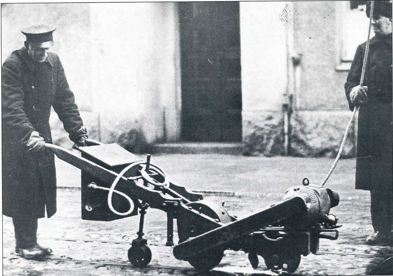
MIESVOIMIN LIIKUTELTAVA KISKON HIOMAKONE 1930-LUVULTA. SÄHKÖVOIMAN TÄMÄ TYÖKONE SAA AJOJOHTOON KYTKETYN KAAPELIN VÄLITYKSELLÄ, OIKEANPUOLEINEN MIES PITÄÄKIN TANKOA PYSTYSSÄ. KOKOELMA J. RAUHALA.
