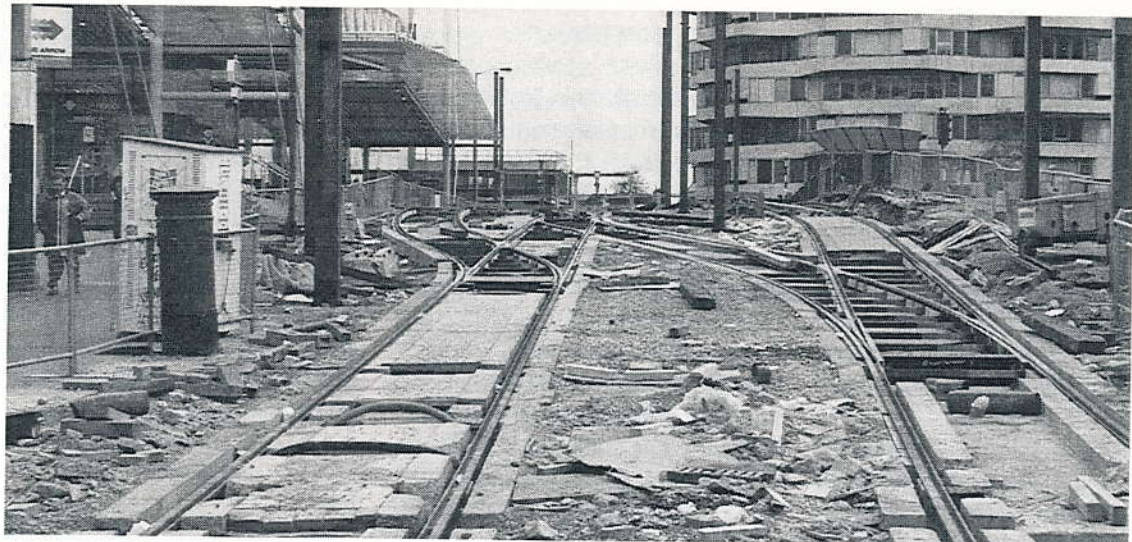
Tramlinkin East Croydonin terminaali rakenteilla 2.4.1999. Raskasrakenteiset ajojohdinpylväät saaneet runsaasti kritiikkiä julkisessa sanassa.
