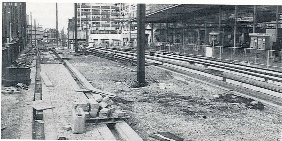
Tramlinkillä käytetään raiteenrakennustekniikkaa, jossa urakiskot upotetaan katuun valmiiksi tehtyihin uriin. Kiskojen ympärille asennetaan ääntä ja tärinää eristävää materiaalia. 2.4.1999
