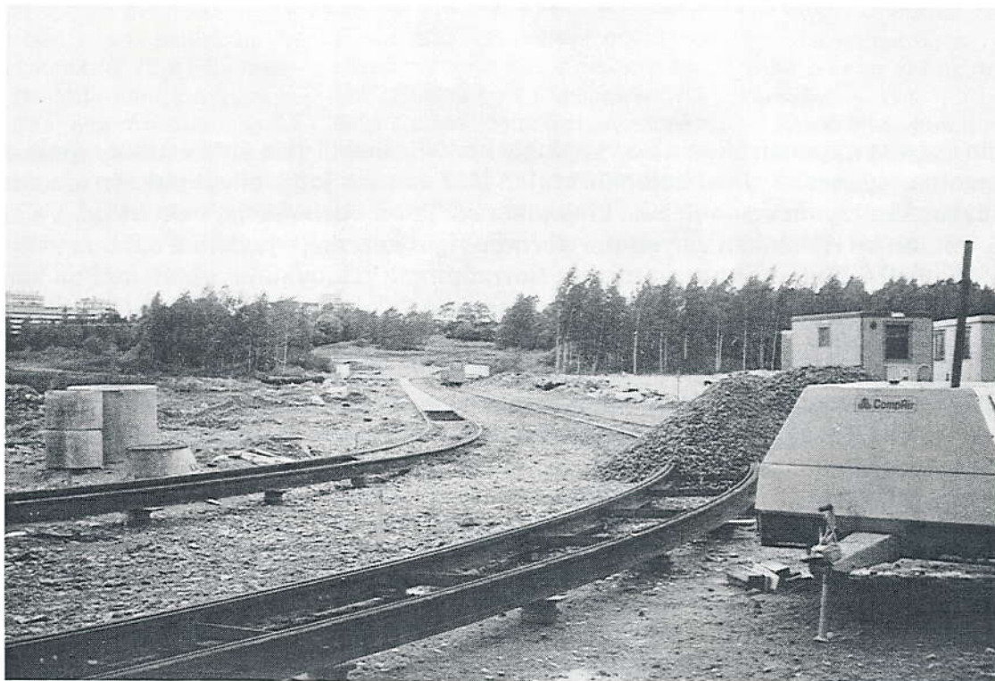
Kiskotustyöt ovat käynnissä Korppaanmäentiellä. Puron ylittävä silta oli melkein valmis, mutta rakennuksista ei ollut perustuksiakaan. J. Tölkö 25.9.1988
