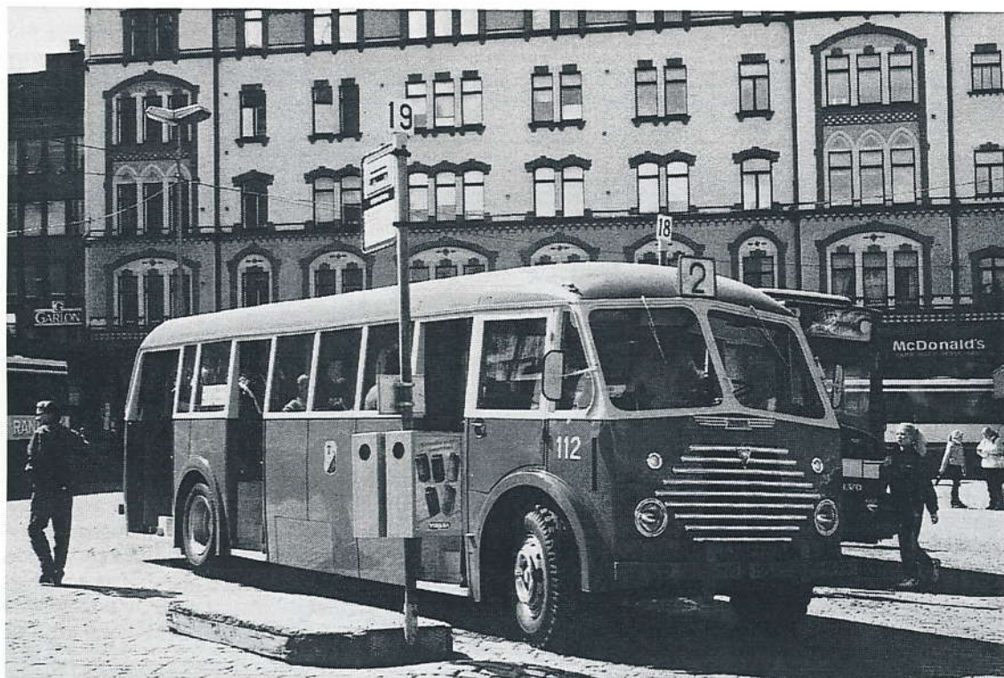
TAKL 112, AEC (eli Aasi) /Valmet vm. 1949 hienosti entisöitynä Tampereen Keskustorilla esittelytilaisuudessa 26.5.1998. Auto kuului liikennelaitoksen ensimmäiseen dieselbussihankintaan. Kuva Jorma Rauhala 26.5.1998, Tampere
