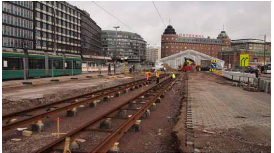
Hakaniemen kiskotyöt olivat käynnissä vappuaattona. Kuva Arto Hellman.
