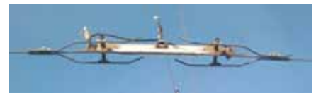
Perinteisissä jaksoerottimissa on puolimetri- nen virraton osuus. Kiinni olevissa erottimissa syöttöjaksot on yhdistetty erillisellä kaapelilla. Kuva Jaakko Pertilä 13.3.2013
